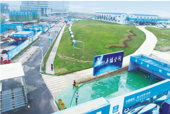
禹洲·武汉南太子湖项目花园式工地
