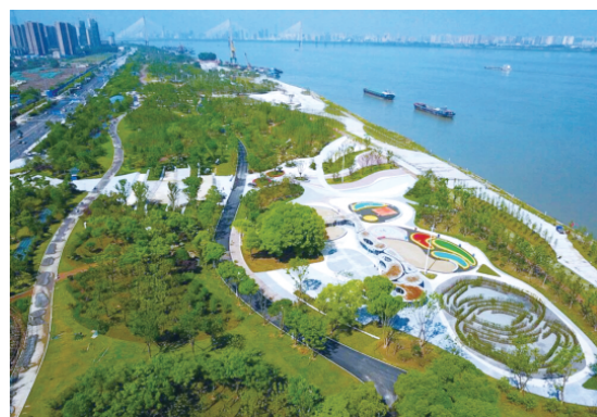
青山江滩三期(建设五路~建设十路)
