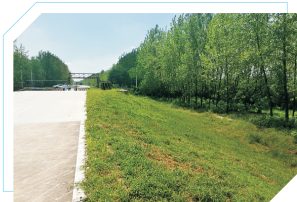
中韩（武汉）石油化工有限公司应急备用取水口工程
