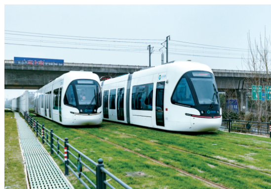
武汉光谷有轨电车T1T2示范线
