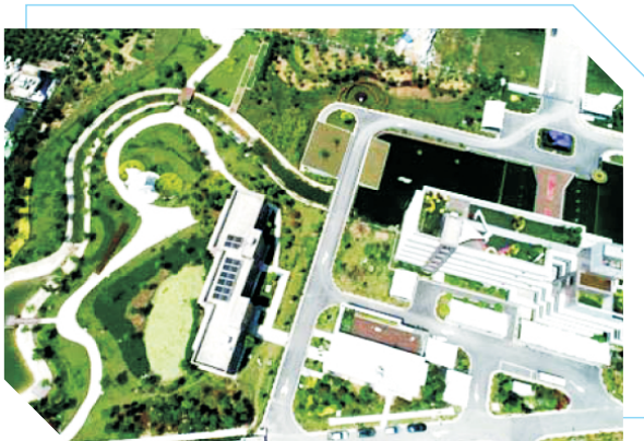
汉西污水处理厂改扩建工程
