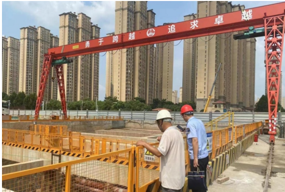
轨道交通12号线（江北段）工程现场检查
