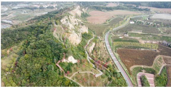
江夏区灵山工矿废弃地复垦利用试点项目 乔灌木综合绿化效果
