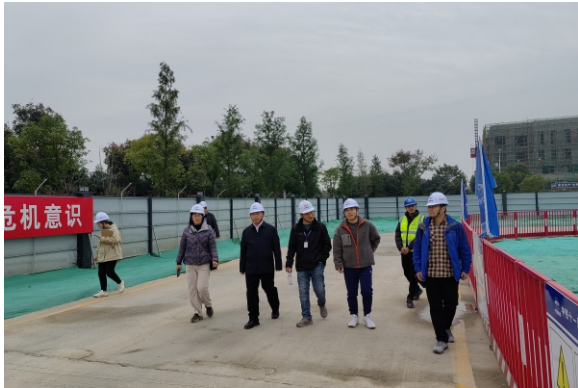
国家华中区域应急救援中心项目现场检查
