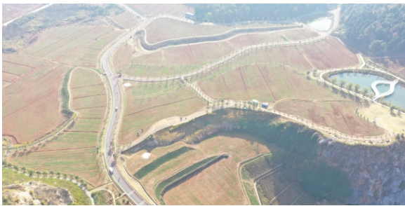
江夏区灵山工矿废弃地复垦利用试点项目 梯田整地工程效果
