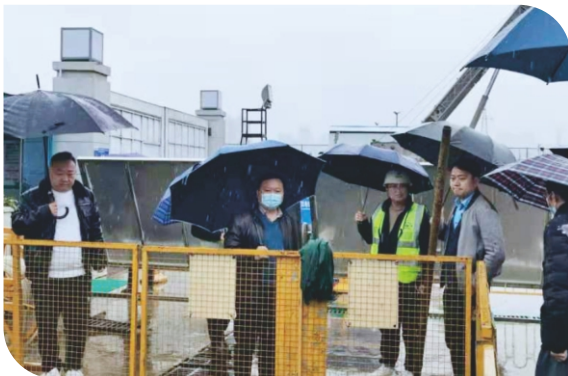
现场检查武汉地铁12号线（通风井工程）
