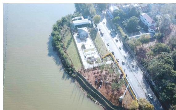
绣球山污水泵站及进出水管道工程
