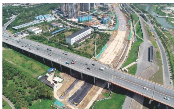
左岸大道穿三环线通道（滨江大道）工程
