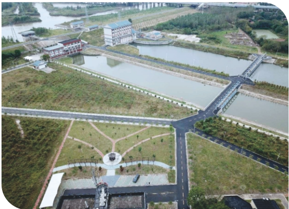
新洲区武湖二泵站灾后更新改造工程
