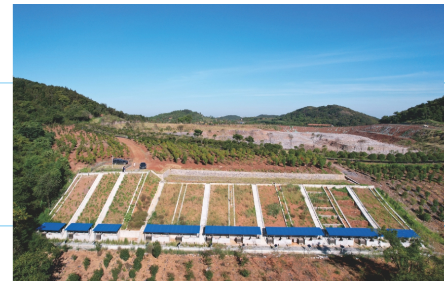
江夏区黑山小流域水土保持监测点新建坡面径流小区
