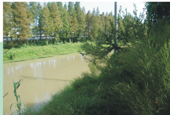
▲ 东西湖区北一干沟水土流失综合整治工程
