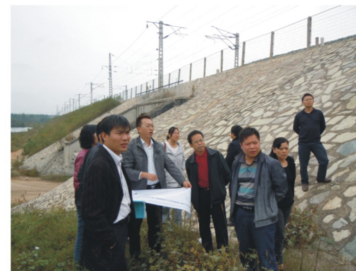
▲ 武汉天兴洲公铁两用长江大桥铁路引桥浆砌石护坡
