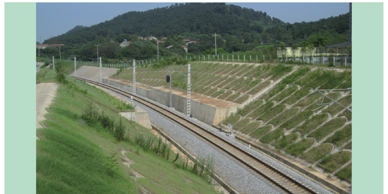
▲ 改建铁路武汉枢纽武汉站货车外绕线及武昌东编组站南疏解工程拱型骨架护坡
