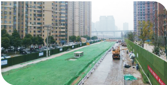
武昌区江南中心绿道武九线综合管廊工程 现场复核
