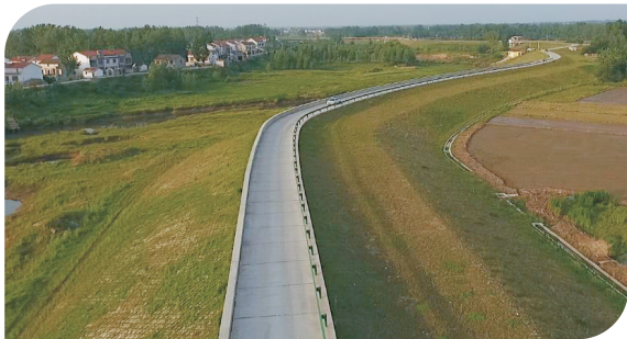
新洲区2016年度河道堤防灾后重建工程完成验收
