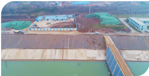
经开区周家河泵站工程堆土场和施工场地 航拍复核
