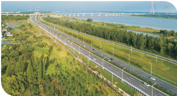
江北快速路工程完成验收
