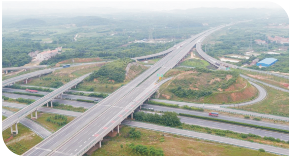
武汉至深圳高速公路武汉段工程完成验收
